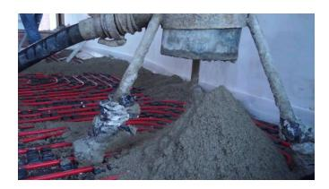
La preparación del mortero se hará según prescripción de proyecto, o se utilizará un mortero industrial específico para suelo radiante.
