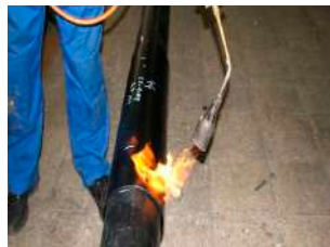
6. Contraer los extremos de la camisa calentando la misma con una antorcha.
