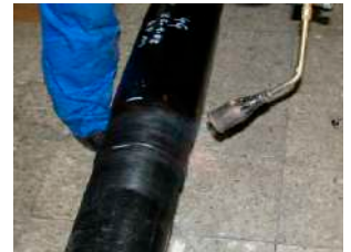
8. Precalentar el área de los extremos del manguito aprox. 70°C.
