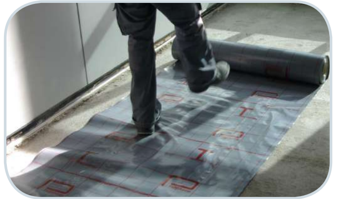
2.- Colocación hoja PE. Debe ser doble y que se eleve 5cm por la pared.
