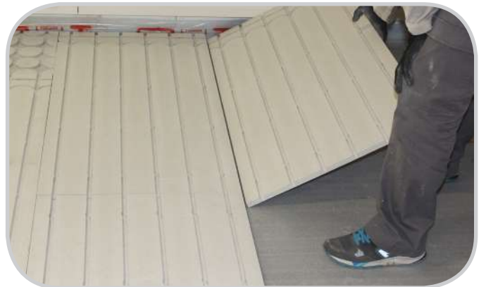
4.- Colocación de las placas con las curvas hacia la pared.
