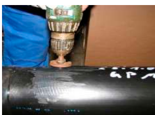
13. Repasar los orificios con una broca.
