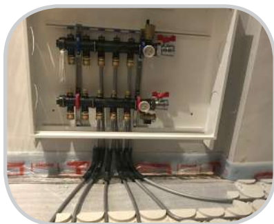
5.- Colocación tubo de los distintos circuitos.
