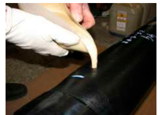
12. Introducir la mezcla de poliuretano por los orificios en la camisa.
