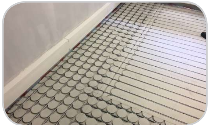
6.- Hacer la prueba de presión. Una vez hecha verter el mortero auto-nivelante.
