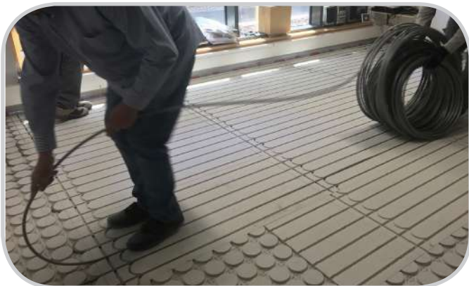
5.- Colocación tubo de los distintos circuitos.
